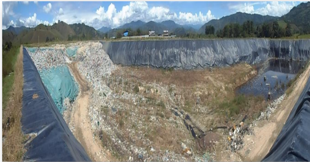
Ilustración 31 Celda de Relleno Sanitario
